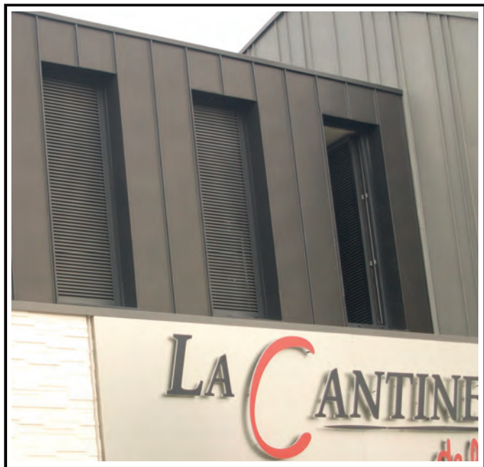
Grille de ventilation en remplacement du vitrage
