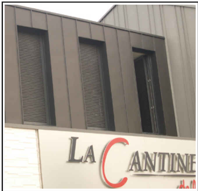
Grille de ventilation en remplacement du vitrage
